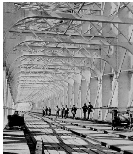
Figuur 3 Foto-impressie Spoorbrug Culemborg
